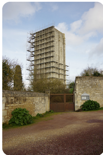
La Tour carrée de Loudun, actuellement en travaux
